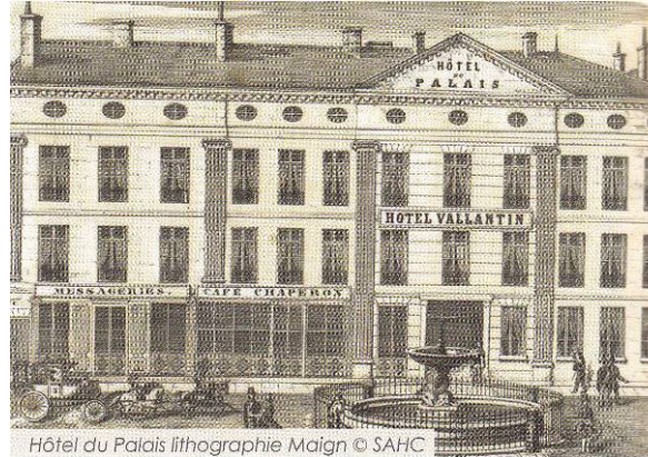
Hôtel du Palais avant qu'il ne soit rehaussé et qu'il ne perde son fronton triangulaire
