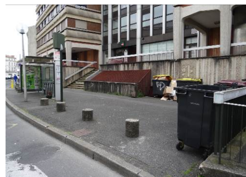
Edicule de ventilation et aire de dépose des ordures ménagères
