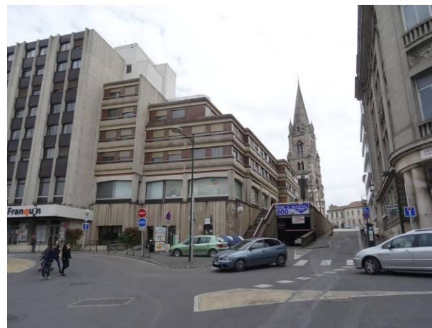
Accès à la rue Jean Jaurès
