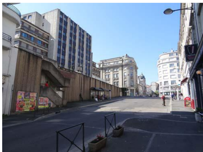
Imposant mur de soutènement du boulevard Berthelot en béton gravillonné
