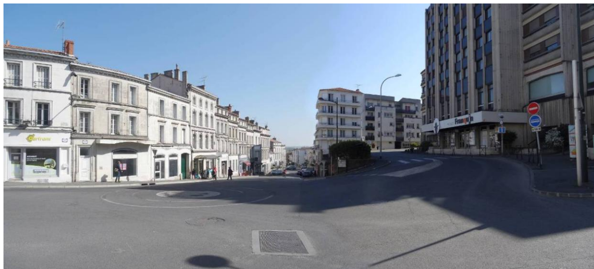
Giratoire en haut de la rampe d'Aguesseau – Forte emprise des sols en enrobé
