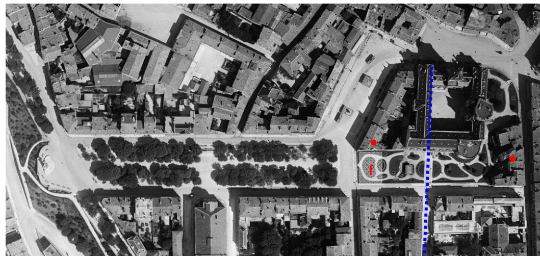
Photo IGN de 1922. L'ancien théâtre Luchet (f) a été démoli en 1912 pour laisser place à la création du square de l'hôtel de ville initié dès la construction de la nouvelle mairie. Des immeubles (●) encore présents en 1922 seront démolis un peu plus tard pour libérer l'espace autour de l'hôtel de ville – Ancienne rue Rivaud (.....) en partie condamnée lors de la construction de la mairie.
