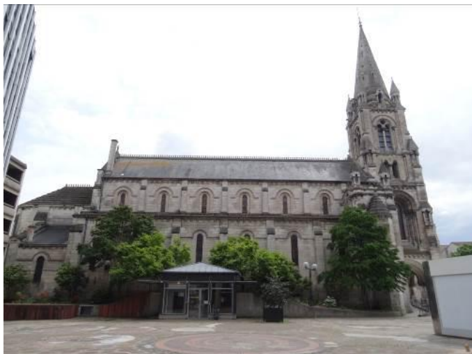
Abords de l'église Saint- Martial – Entrée d'accès piéton au parking souterrain – Edicules de ventilation et plantation
