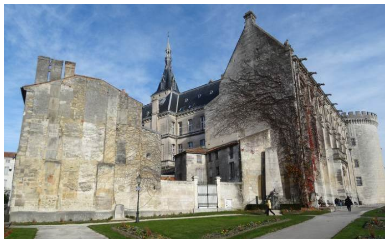
Mur dégagé suite à la démolition d'un bâtiment contre l'hôtel de ville, une construction nouvelle adossée serait souhaitable
