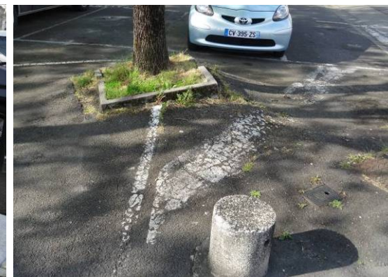
Déformation du sol par le système racinaire des féviers d'Amérique
