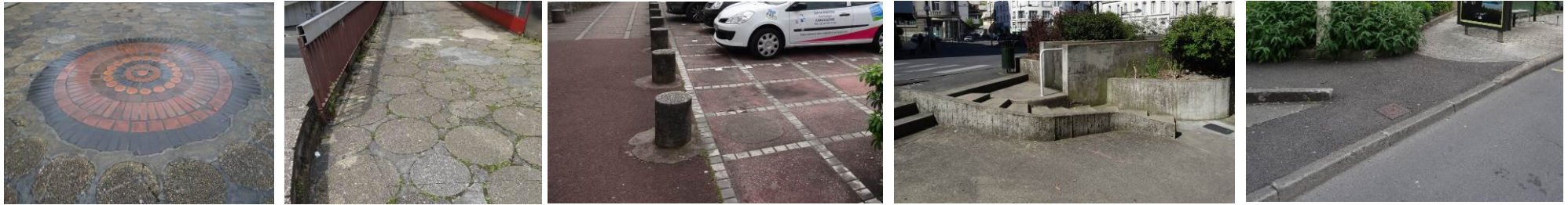
Dalles de béton grillonnées rondes, damier en enrobé rouge délimité par un trame en petits pavés de béton clair, brique, béton brut, enrobé noir, dalles calcaire
