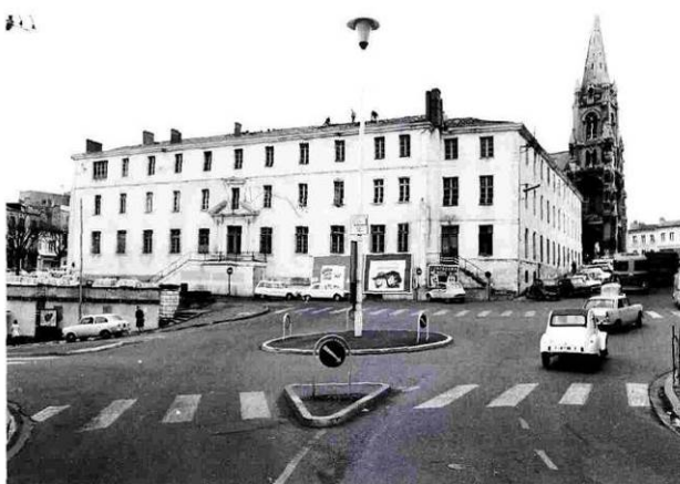
Le séminaire avant sa démolition dans les années 1970. Le bâtiment a été agrandi par rapport à celui d'origine.
