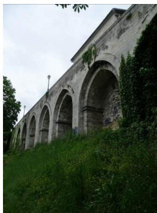
Mur de soutènement à arcs brisés
