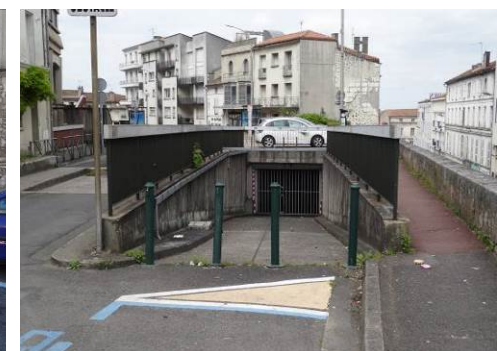
Trémie d'accès au parking Saint-Martial condamné
